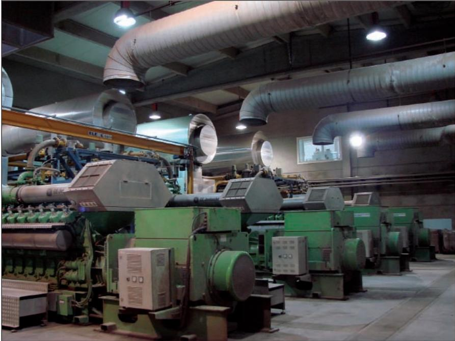
Motores para la generación de energía eléctrica.
