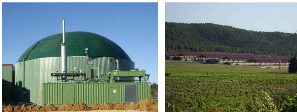
Figura 2. Vista del post-digestor con el motor en el frente (izquierda) y vista general de las instalaciones de la Granja San Ramón en Campo Arcís.
