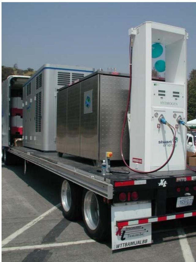
Figura 9. Cabinas de compresión y almacenamiento con surtidor de CNG
