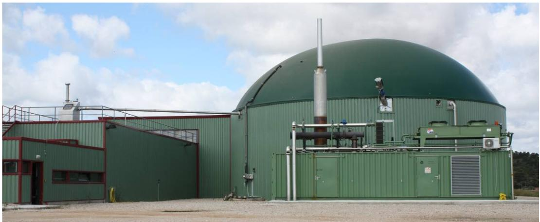
*Figura 4. Planta de biogás agroindustrial de la Granja San Ramón, donde se realizaron las pruebas industriales de demostración de la codigestión de cultivos y deyecciones ganaderas.*
